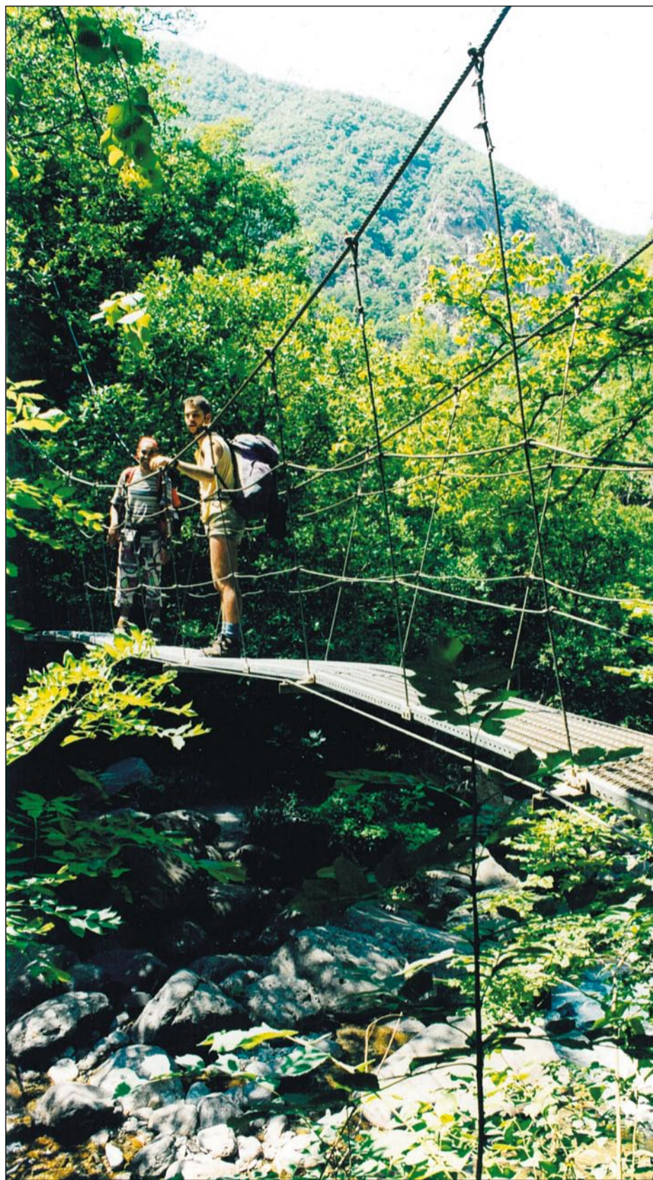
La Vall de Carançà té passarel·les i ponts metàl·lics que no donen cap problema si es va amb precaució
